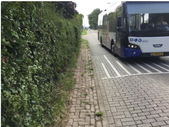
Foto 1. Goot en drempel in Bovenstraat
