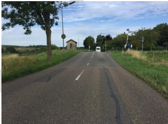
Foto 2. Hoogwaterkering in Bovenstraat-Sluisweg
