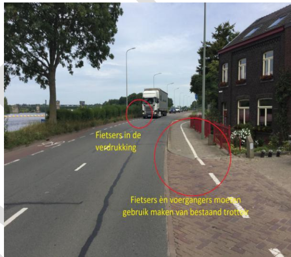
Foto 5. Locatie van (brom)fietsers op de rijbaan: het vrachtverkeer rijdt er vlak langs terwijl aan de overzijde (brom)fietsers van het trottoir gebruik moeten maken: een onwenselijke situatie.
